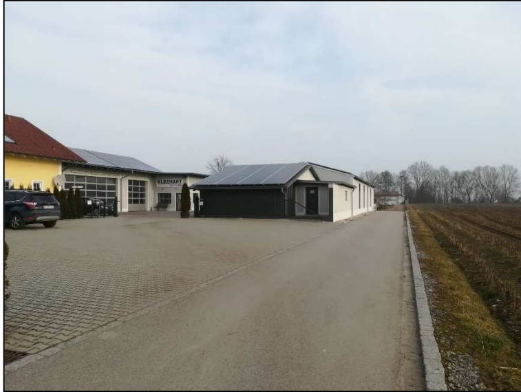
Bestehender Kfz-Betrieb westlich des Plangebietes.
